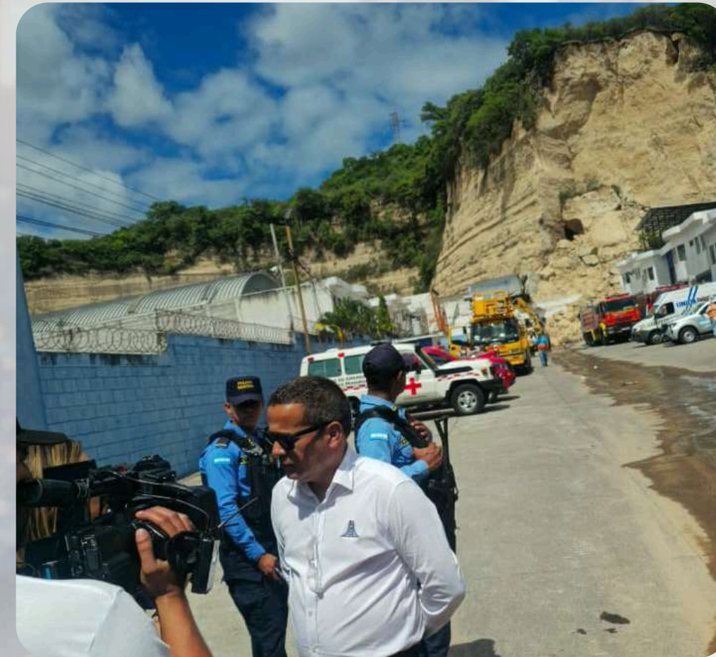
Derrumbe Anillo Periferico
